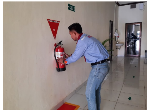
Gambar 2 Perhitungan Jumlah APAR dan Peletakkannya
